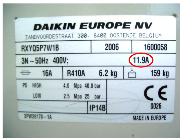
Рис.1 Величина тока MCA=11,9 А на шильде наружного блока системы VRF
